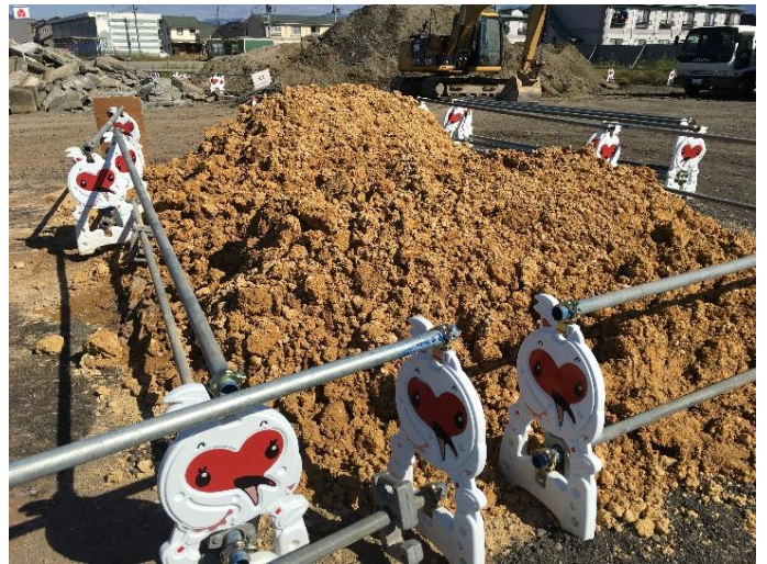
生コン残さをAC-096にて改良したもの
